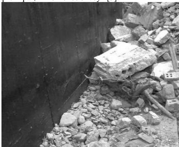
Рис. 2. Устройство обратной засыпки пристенного дренажа с использованием строительного мусора
