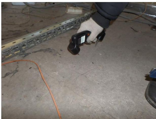
Фото 2. Испытание монолитной плиты перекрытия ультразвуковым методом прибором Пульсар-2М
