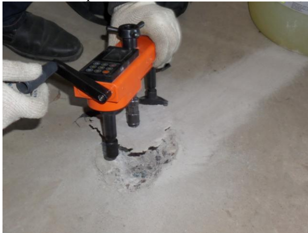
Фото 1. Испытание монолитной плиты перекрытия метом «отрыв со скалыванием» прибором ОНИКС-ОС
