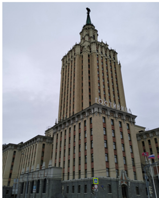
Рис. 1. Высотное здание гостиницы «Ленинградская», Москва (фото автора – Маяцкая И.А.)
