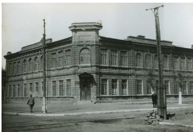
Рис. 7. Историческое состояние здания бывш. Здание Ольгинского (4-го городского) женского училища [32]
