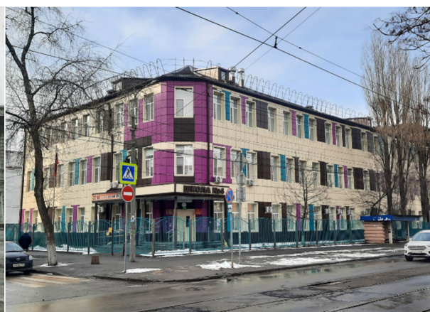
Рис. 8. Современное состояние здания бывш. Здание Ольгинского (4-го городского) женского училища. (Фото автора, 2024 г.)
