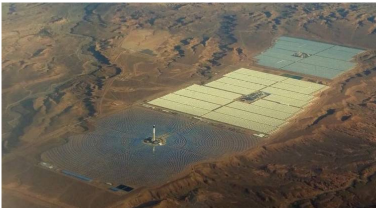
Рис. 1 - Солнечная электростанция Нур-Уарзат
