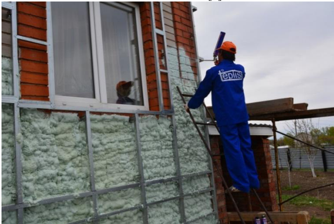
Рисунок 8. Утепление с помощью напыляемого ППУ «Теплист»
