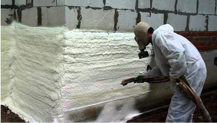
Рисунок 7. Напыление ППУ на цоколь дома
