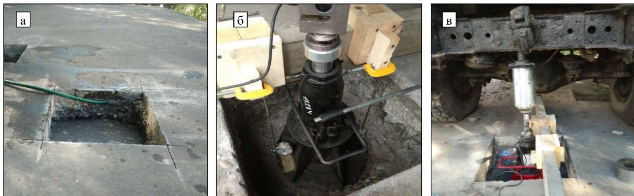
Рис. 3. Проведение штамповых испытаний земляного полотна из ЗПС:
