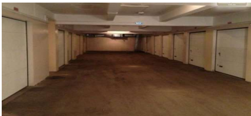
Рис. 3. Подземный паркинг по адресу ул. Победы, 165
