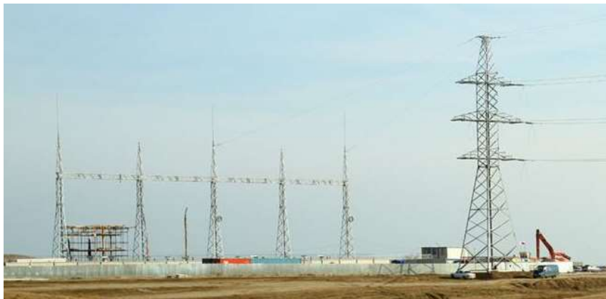
Рис. 2. Общий вид части подстанции «Кафа» [11] с применением 3-х молниеприемников стержневого типа на одном из порталов (показано на момент строительства)
