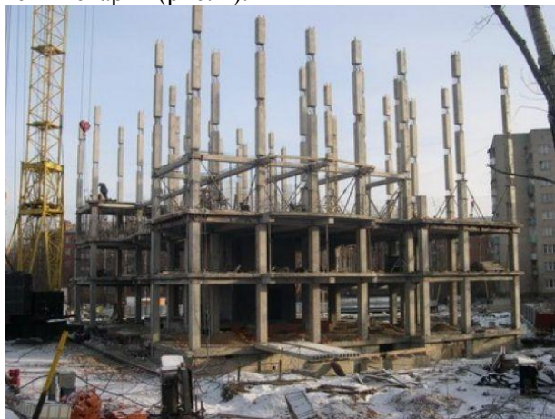
Рисунок 1. Конструкция сборно-монолитного здания
