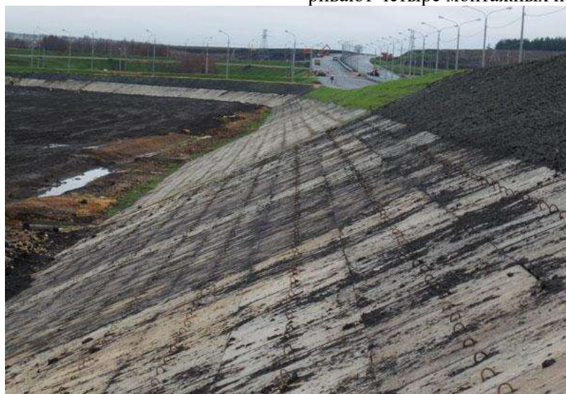
Рис. 4. Укрепление насыпи бетонными плитами
