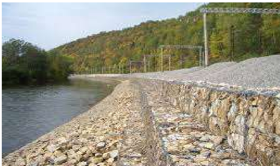
Рис. 3. Укрепление каменной наброской
