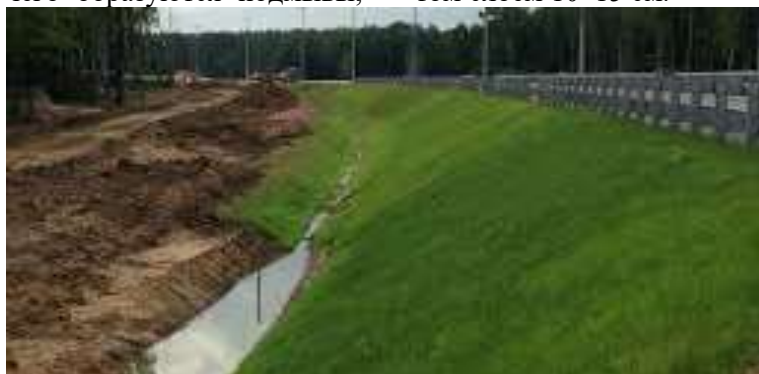
Рис. 1. Укрепление насыпи засевом трав
