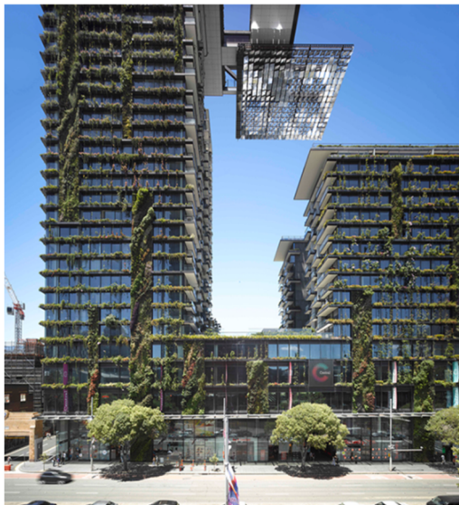
Рис. 7. Общий вид здания «One Central Park», г. Сидней (Австралия)
