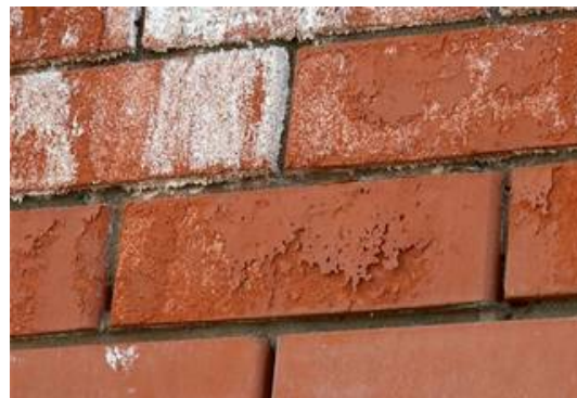
Рис. 1. Разрушение кирпичной стены
