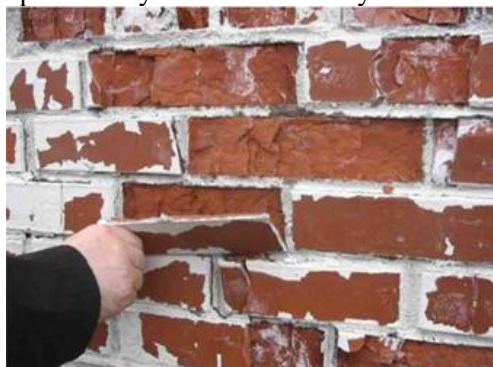
Рис. 1. Разрушение кирпичной стены
