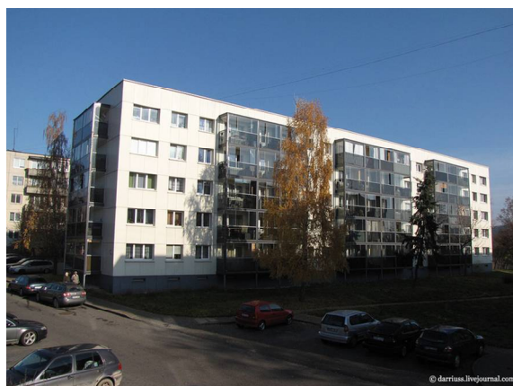
Рис. 3 Реновация панельного жилого дома в районе Жирмунай города Вильнюс, Литва:
