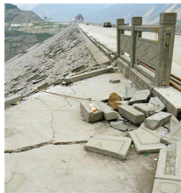
Рис. 4. Фрагменты повреждения плотины «Зипингпу» во время землетрясения [9]
