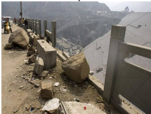
Рис. 4. Фрагменты повреждения плотины «Зипингпу» во время землетрясения [9]
