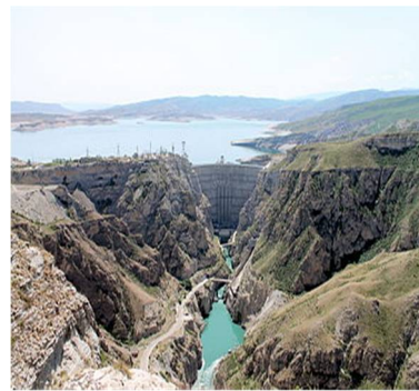
Рис. 6. Панорама Чиркейского ущелья, водохранилища и ГЭС [13]
