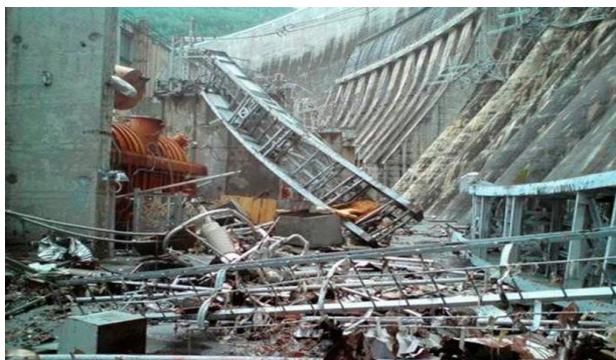
Рис. 7. Август 2009 г., авария на Саяно-Шушенской ГЭС (Россия)
