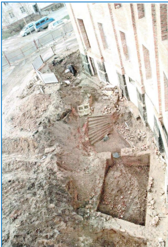
Рис. 4. Раскопки отопительной системы собора
