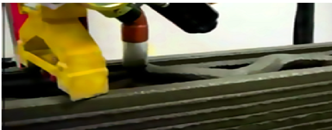
Рис. 5. Возведение стены путем экструдирования из рабочего «сопла» бетонной смеси на ранее выложенный слой
