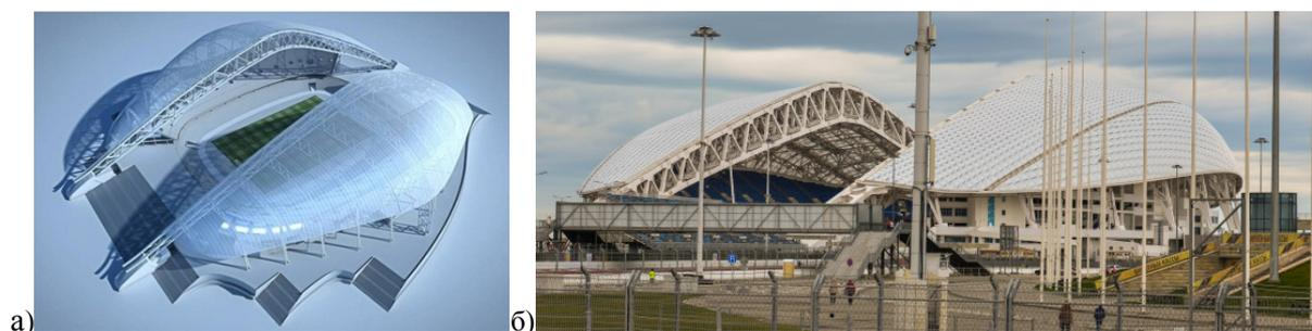
Рис. 7. Главной особенностью конструкции являются две гигантские балки, на которых держится стеклянная крыша: а) модель стадиона «Фишт», б) фото стадиона
