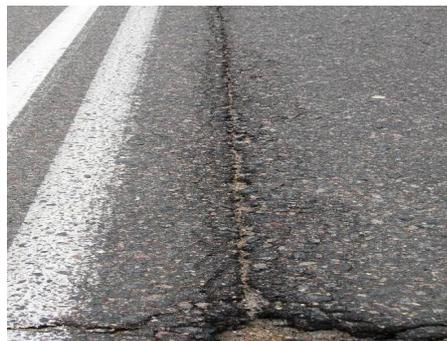
Рис. 3. Разрушение покрытия в зоне технологической трещины
