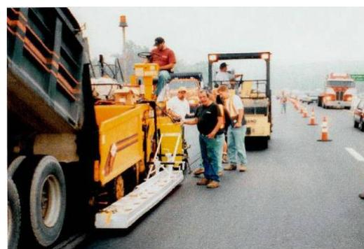
Рис. 16. Системы инфракрасного прогрева на асфальтоукладчике
