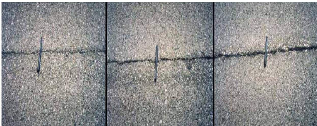
Рис. 1. Динамика разрушения «технологических» трещин покрытия
