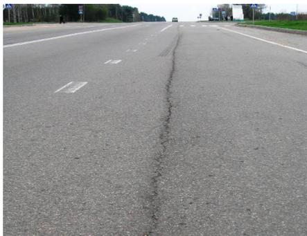
Рис. 2. Технологическая трещина
