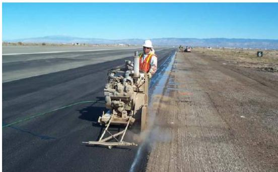
Рис. 13. Обрезка кромки алмазным диском
