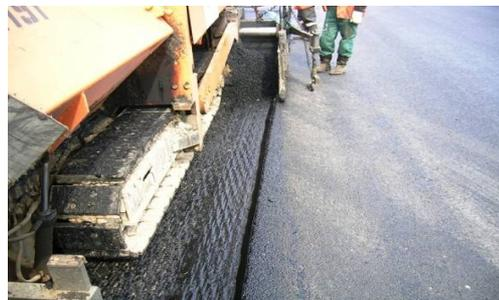
Рис. 24. Укладка смеси с применением стыковочной ленты
