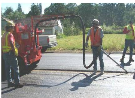
Рис. 21. Специализированный заливщик для нанесения мастики
