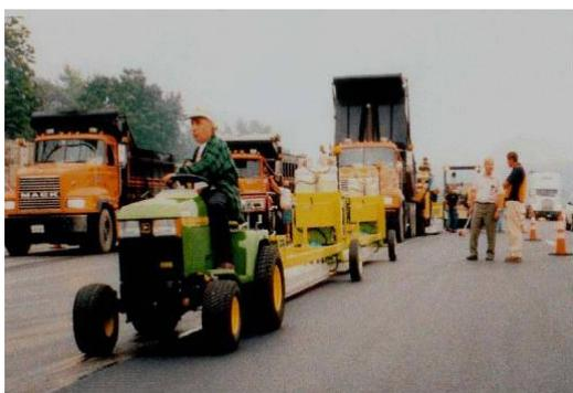
Рис. 15. Система инфракрасного прогрева на автономном шасси
