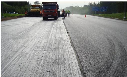
Рис. 23. Укладка стыковочной ленты вдоль кромки покрытия
