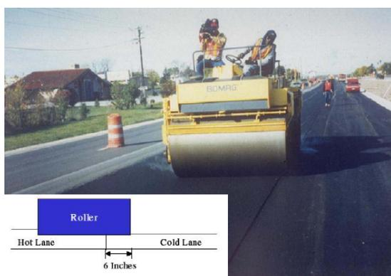
Рис. 25. Уплотнение с перекрытием смежной полосы
