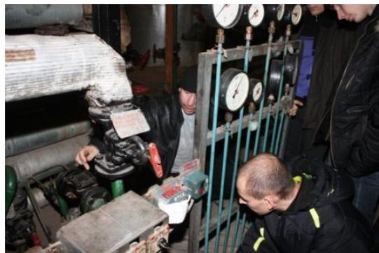
Рис. 3. Вентиль и обратный клапан
