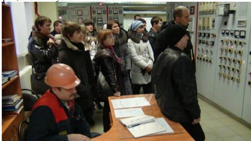
Рис. 1 Щит управления котельной
