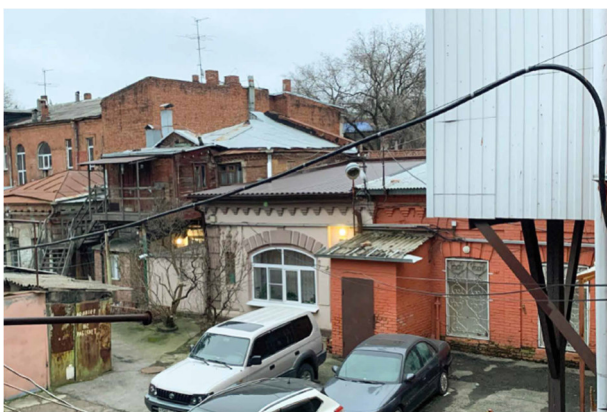
Рис.14. Фасады хозяйственных пристроек (каретной и хозяйственной пристройки) 1904 года. Фрагмент южного дворового фасада. Фото Гривко А. К., 2024 г.
