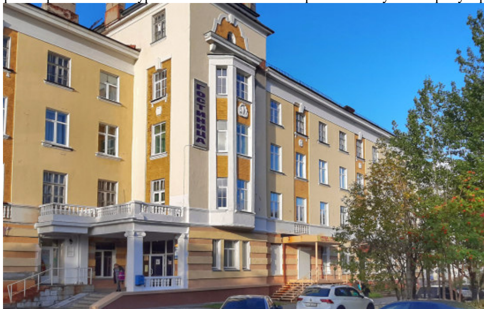
Рис. 8. Мончегорск. Гостиница «Север». Настоящее время [Источник: Электронный ресурс https://travel.murman.ru/murman/south.shtml ]
