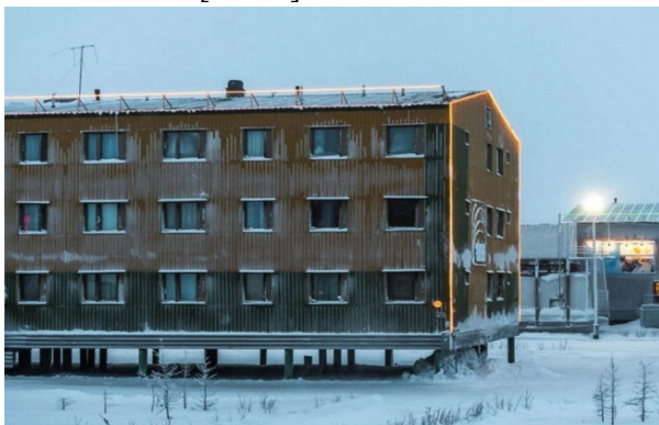
Рис. 5. Проветриваемое подполье в жилом доме [Источник: https://dzen.ru/a/ZF-4jF4IjXaBqpV7 ]
