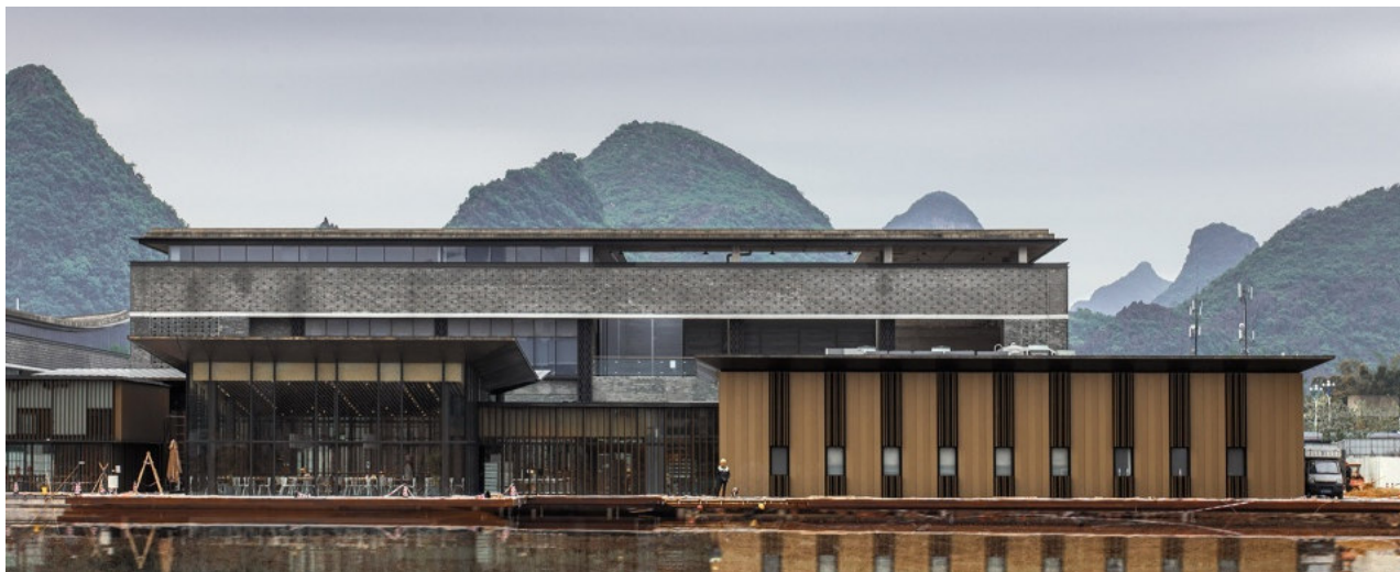
Рис. 4. Фабрика Integral компании Esquel. Г. Гуялинь провинции Гуанси, Китай. Фасад здания
