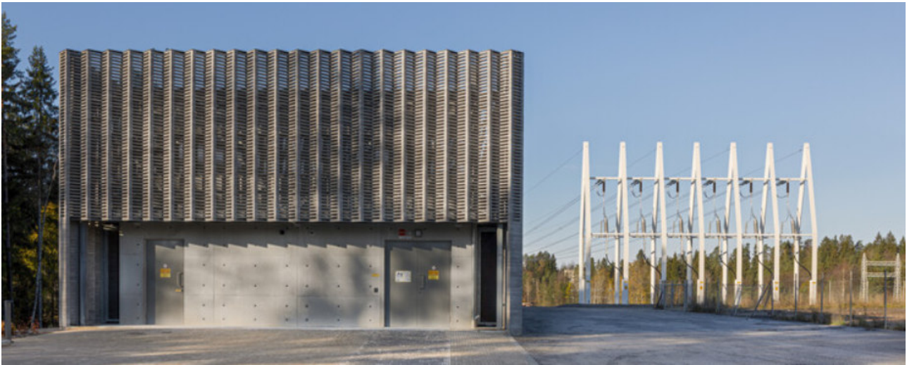
Рис. 2. Электрическая подстанция. Иматра, Финляндия. Авторы: бюро Virkkunen & Co. 2020 г.
