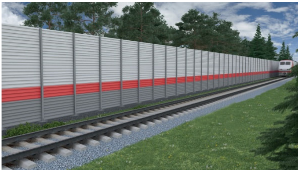
Рис. 1. Шумозащитное ограждение железной дороги.
