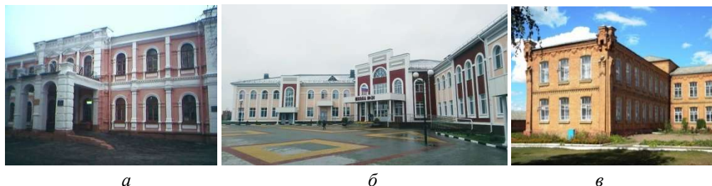
Рис. 4. а – Здание бывшей усадьбы княгини Волковой (1874г.), с 1924 г. СШ №24; б – Новое здание СОШ № 24 (2020г.), г. Белгород, в – Здание СОШ №1 п. Уразово, Валуйский р-н, бывшее ремесленное училище 1910 г., сегодня – один из корпусов школы
