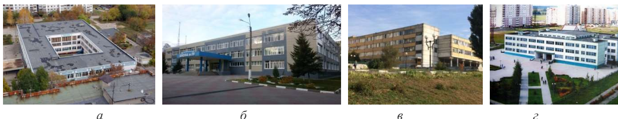
Рис. 8. Строительство общеобразовательных школ по ТП в конструкциях серии ИИ-04. а – Шуховский лицей № 38 в г. Белгороде; б – Общеобразовательная школа № 39 в г. Белгороде; в – Общеобразовательная школа № 49 г. Белгород 1980–1990 гг.
