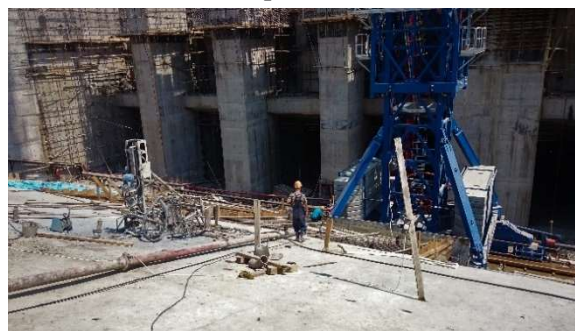
Рис. 9. Бетонирование блока. Трубопровод подачи бетонной смеси. Бурильная установка
