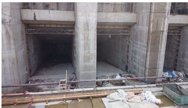
Рис. 2. Проходные отверстия блока агрегатов с генераторами
