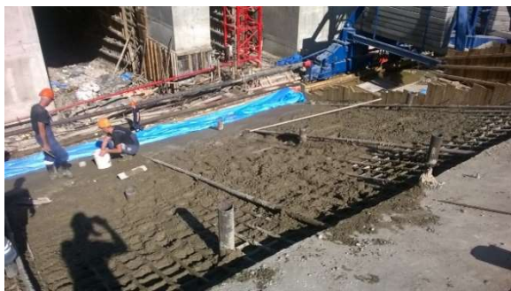
Рис. 8. Бетонирование блока. Процесс создания ровной поверхности
