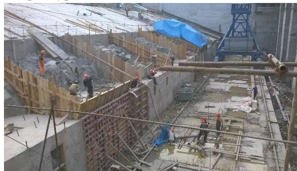
Рис. 7. Армирование бетонного блока. Подготовленный ряд блоков для заливки их бетоном
