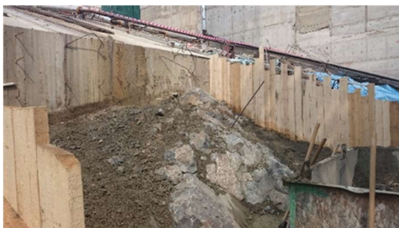
Рис. 5. Установленная опалубка на заключительном этапе очистки скалы
