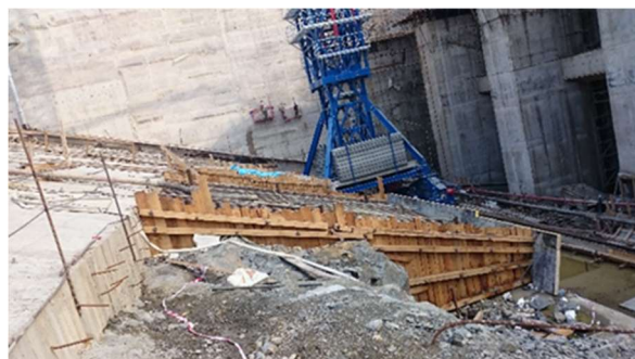
Рис. 6. Участок наклонной плоскости, подготовленный к бетонированию, а также забетонированный предыдущий блок с арматурными выпусками
