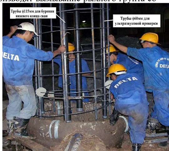
Рис. 6. Установка труб для ультразвукового контроля качества ствола свай и бурения ее нижнего конца
