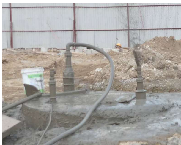
Рис. 10. Нагнетание раствора тонкодисперсного вяжущего вещества под давлением в нижнюю часть буронабивной сваи
