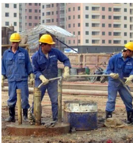
Рис. 10. Нагнетание раствора тонкодисперсного вяжущего вещества под давлением в нижнюю часть буронабивной сваи
