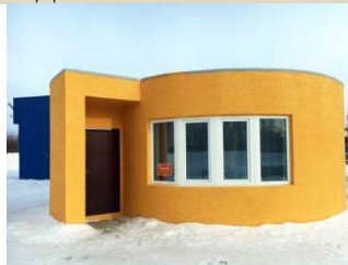
Рис. 2. Современная практика строительства 3D-принтером [10–15]
