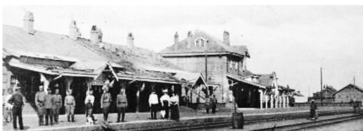
Рис. 5. Вид на восточную часть вокзального комплекса станции Цицикар (фрагмент открытки)
