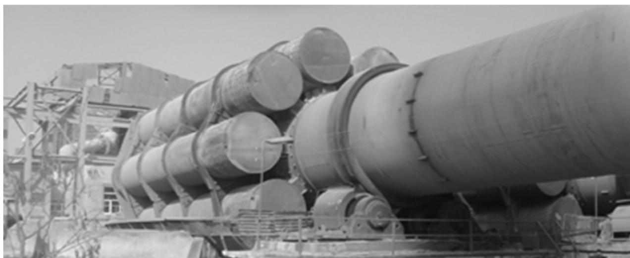
Рис. 3. Печь с рекуператорными холодильниками
