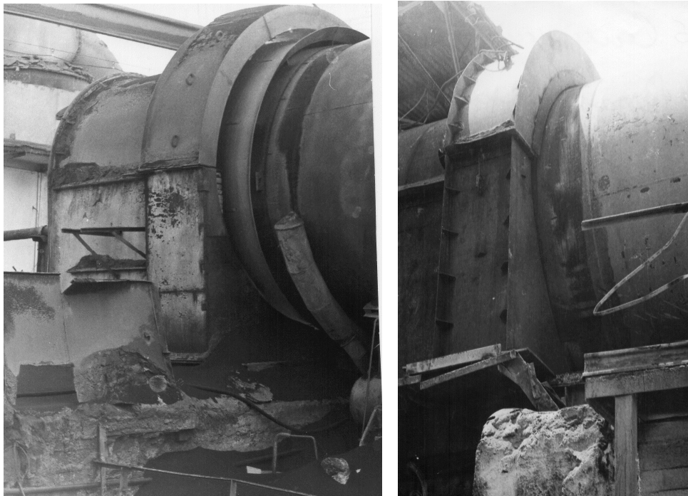
Рис. 3. Отсутствие уплотнительного устройства
