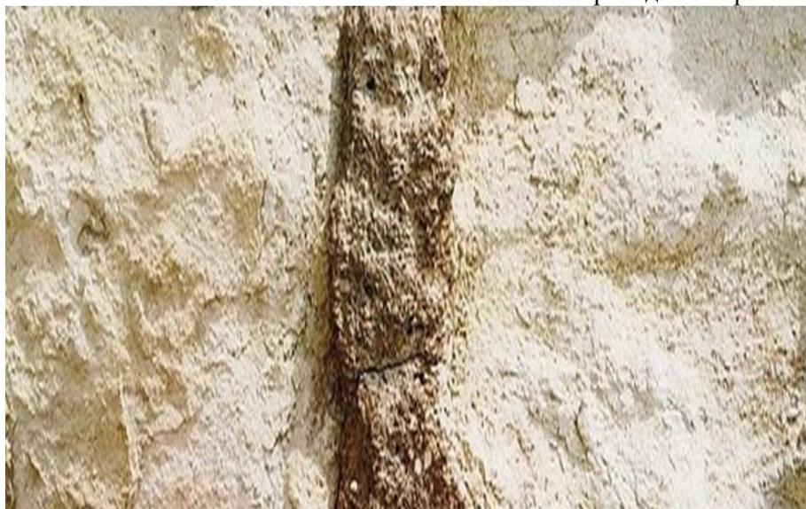
Рис. 1. Шов между блоками кладки пирамиды Хефрена, сына Хеопса, на Плато Гиза, заполненный оригинальным древним раствором из гипса
