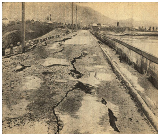
Рис. 5. Повреждения плотины Чирюртской ГЭС при Дагестанском землетрясении 14.05.1976 г. [Красников Н.Д., 1981г.]
