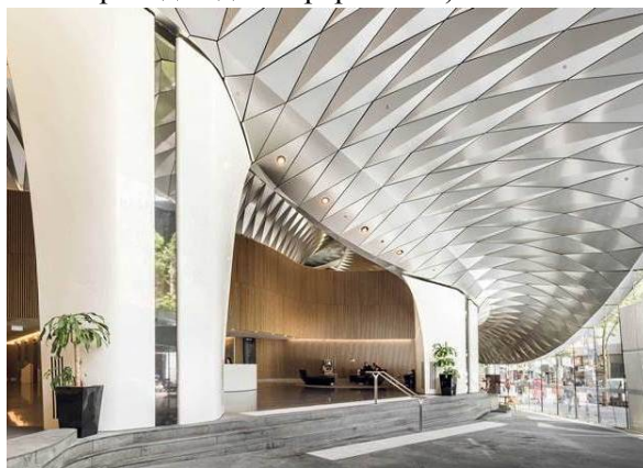
Рис. 7. Пример отделки фасадов зданий панели швейцарского производителя Alucobond, имитирующие металлическую поверхность
