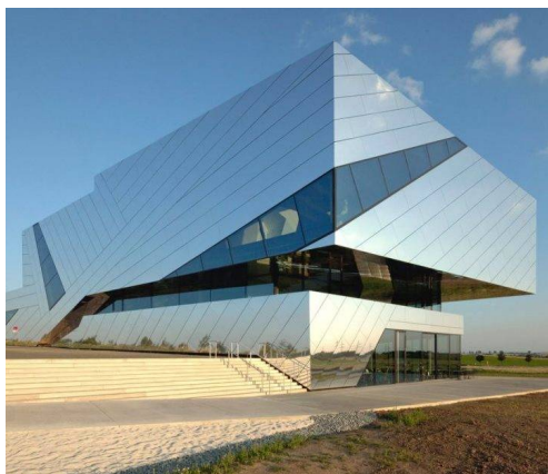
Рис. 7. Пример отделки фасадов зданий панели швейцарского производителя Alucobond, имитирующие металлическую поверхность
