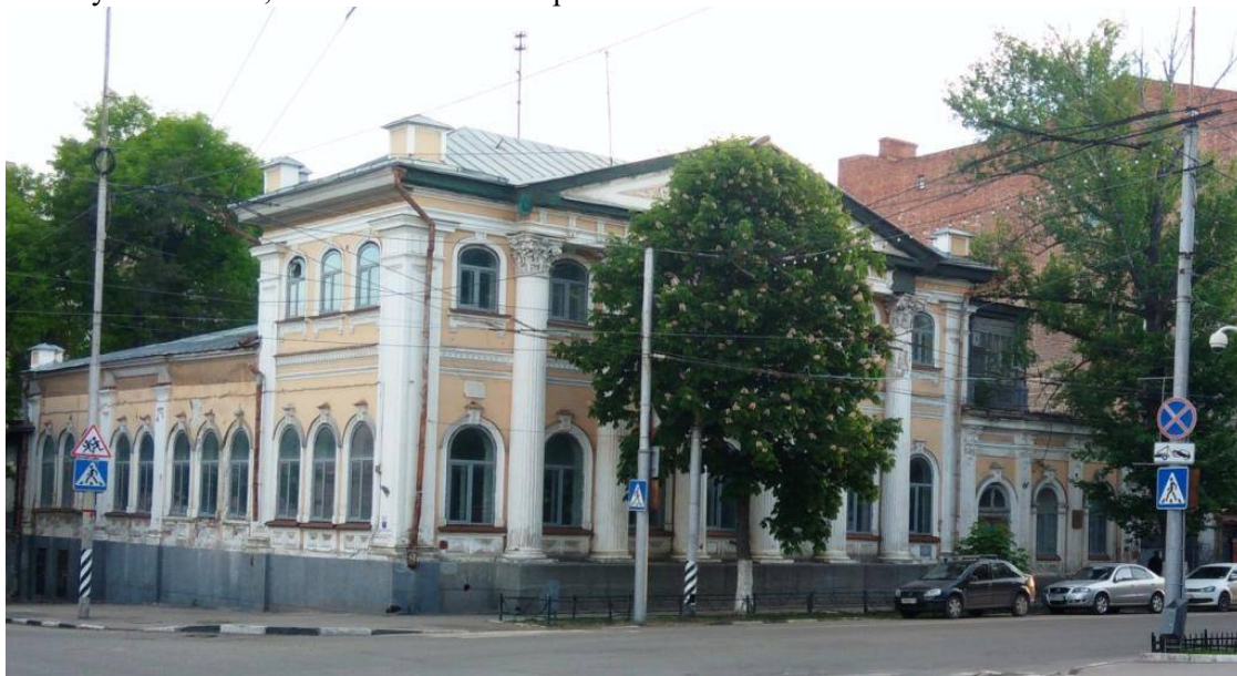
Рис. 1. Общий вид здания
