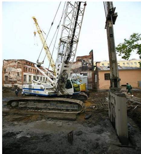
Рис. 1. Двухчелюстной напорный грейфер
