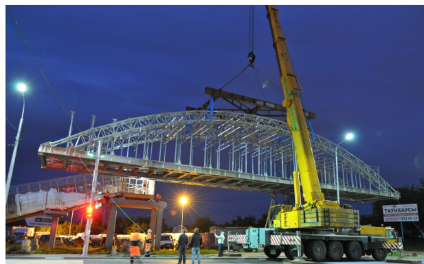
Фото 8. Монтаж пешеходного моста, 2017 год
