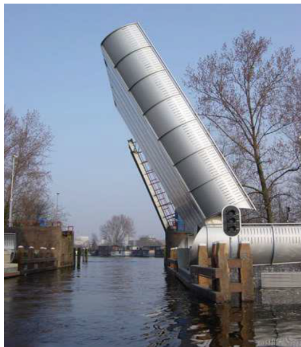
Фото 3. Подъемный мост Riekerhavenburg в Нидерландах
