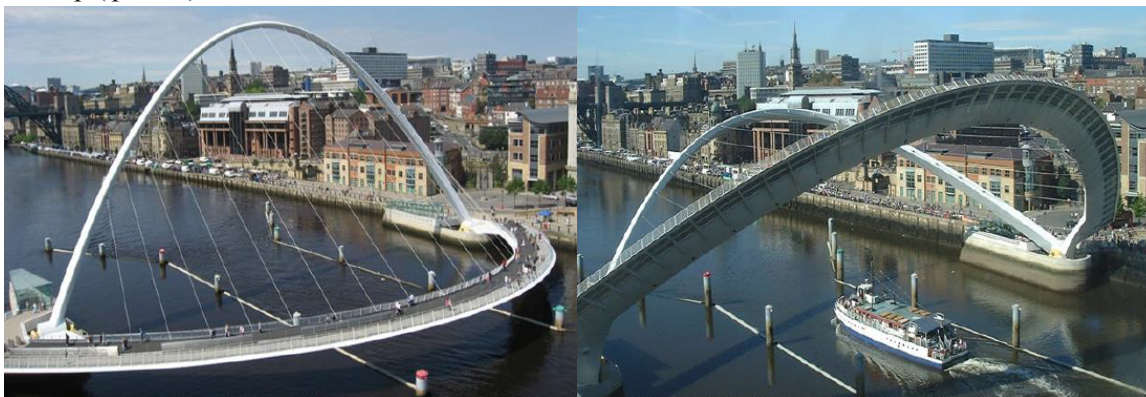
Фото 5. Подъемный мост Gateshead Millennium Bridge, Англия:
