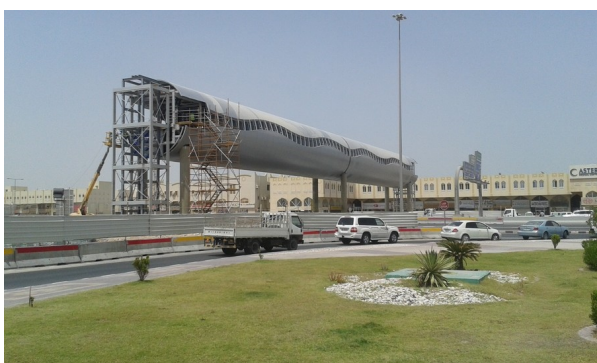
Фото 6. Пешеходный мост, Катар
