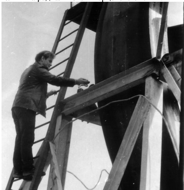
Рис. 1. Измерение биения поверхности качения бандажа (операция 005)
