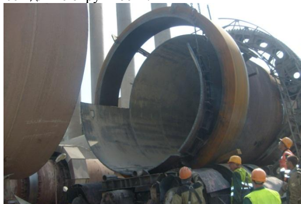
Рис. 3. Демонтаж бандажа с ТБ (операция 015)
