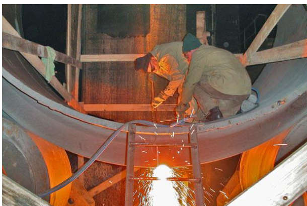
Рис. 7. Сборка реконструированного бандажа с кольцевыми обечайками, с использованием электрошлаковой сварки (операция 025)
