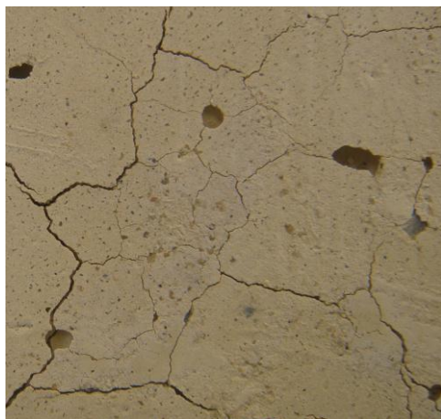
Рис. 3. Сетчатые трещины на поверхности бетонных кубиков, состав №1 прошедшего ТВО, через 3 суток твердения на сквозняке при скорости движения воздушных масс 0,7 м/с
