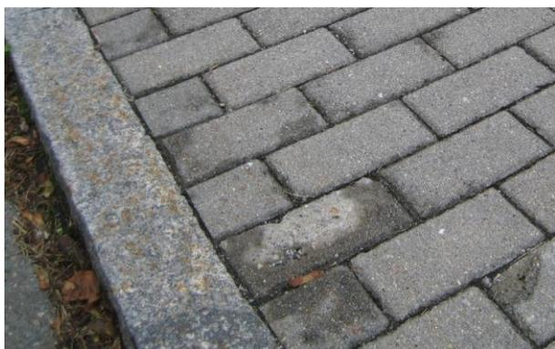
Рис. 3. Желто-коричневые пятна на бетонных изделиях
