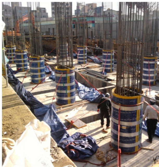
Рис. 2. Картонная опалубка для колонн и балок
