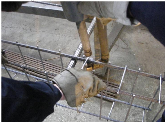
Рис. 2. Операция приварки поперечной арматуры и образцы для испытания
