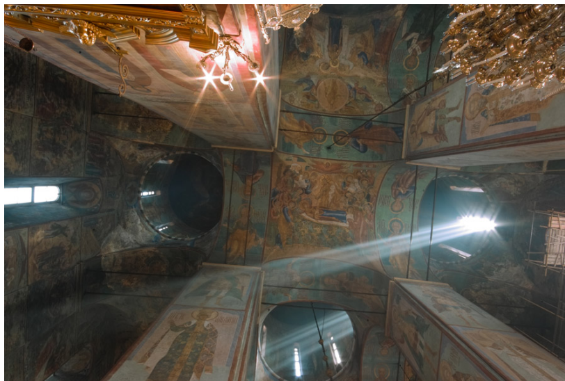
Рис. 1. Подпружная арка Успенского собора Троице-Сергиевой Лавры после реконструкции
